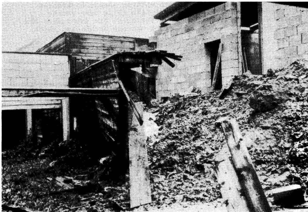
Links, letzte Hochblende der alten 25 m-Bahn, die eingefallene Seitenwand. Rechts oben, der Unterstand der neuen Pistolenbahn.
